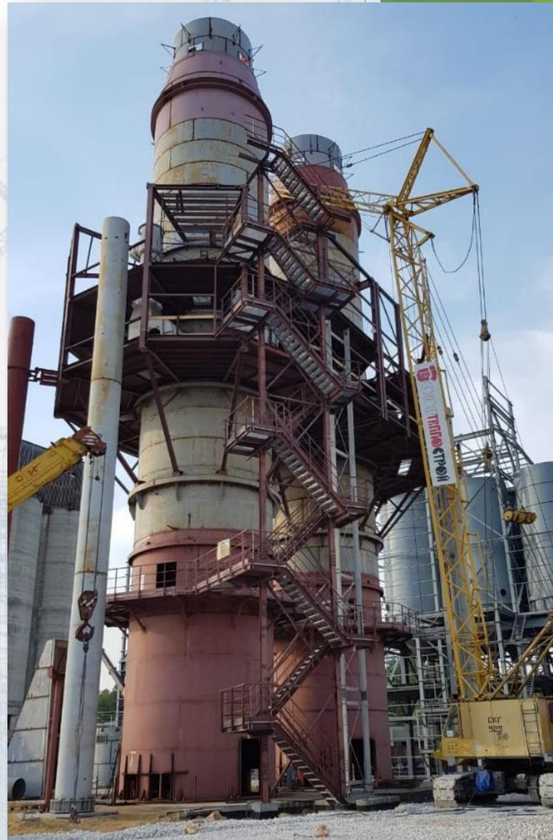
**Сборка и монтаж металлоконструкций, огнеупорная футеровка 2-х кольцевых шахтных печей
