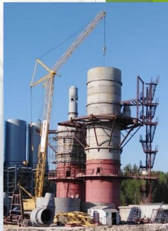
**Сборка и монтаж металлоконструкций, огнеупорная футеровка 2-х кольцевых шахтных печей ASK – Polysius производительностью 300 тонн извести в сутки каждая**
