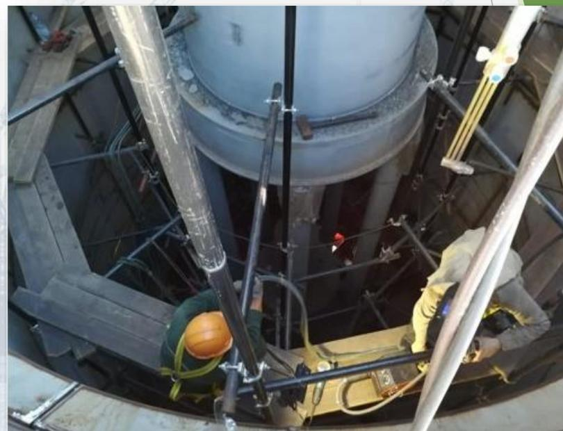
**Сборка и монтаж металлоконструкций, огнеупорная футеровка 2-х кольцевых шахтных печей ASK – Polysius производительностью 300 тонн извести в сутки каждая**
